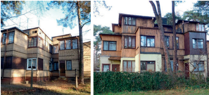
Ryc. 16. Budynki o bardzo złożonej bryle: ul. Piotrkowska 11 (z lewej) i ul. Wileńska 8 (z prawej), fot. K. Błaszczuk, 2017
