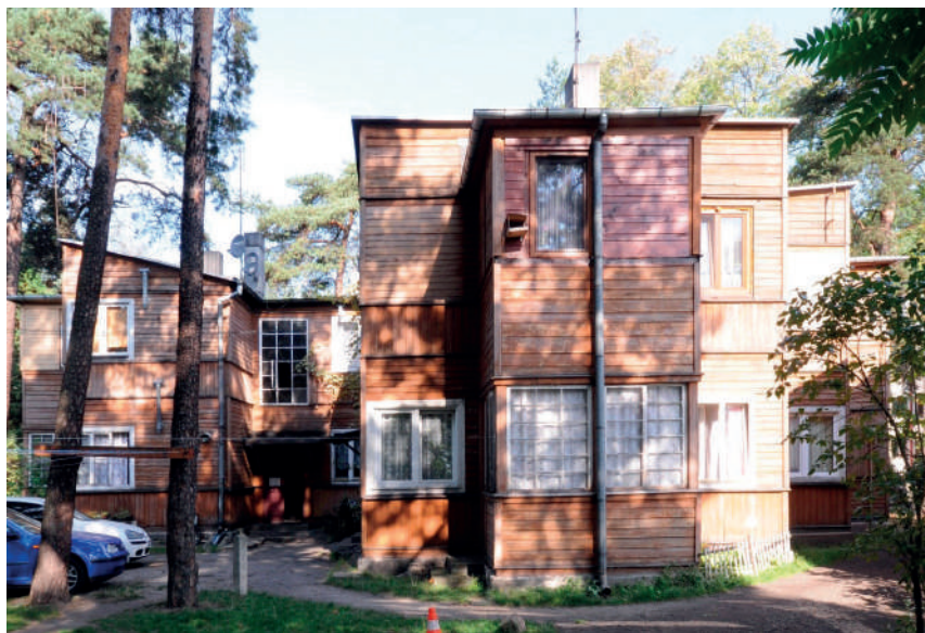
Ryc. 2. Budynek przy ul. Jagiełły 10 – widok od wschodu, fot. W. Pardala, 2014
