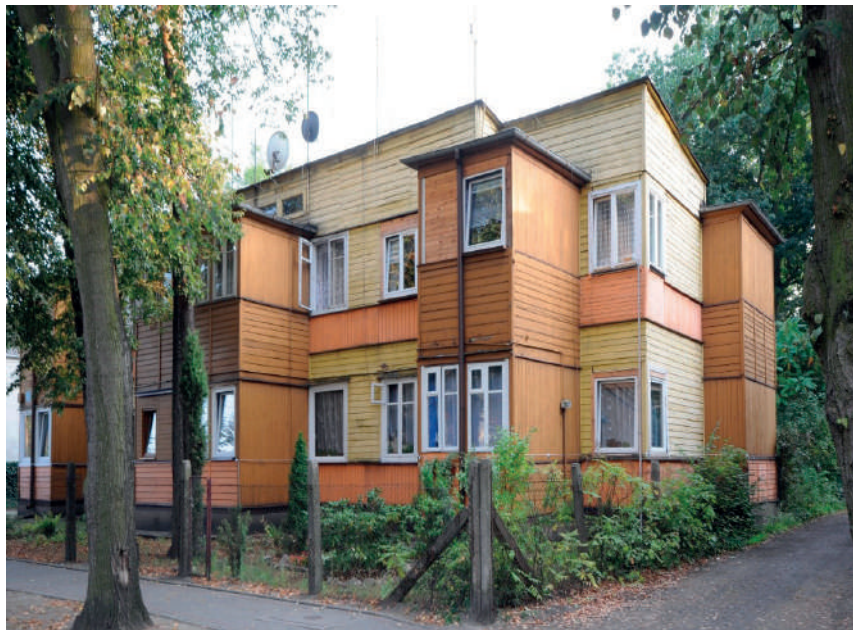
Ryc. 1. Budynek przy ul. Jagiełły 8 – widok od ulicy, fot. W. Pardala, 2016
